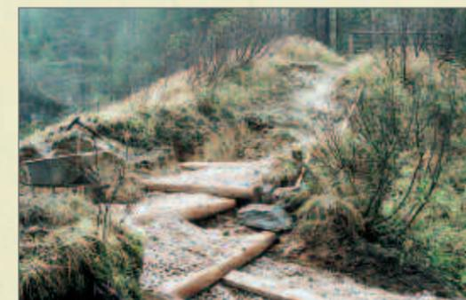
Entlang des Erosionsgrabens werden Holzbalken eingebaut.
